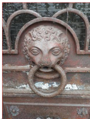
A) Rusted door
